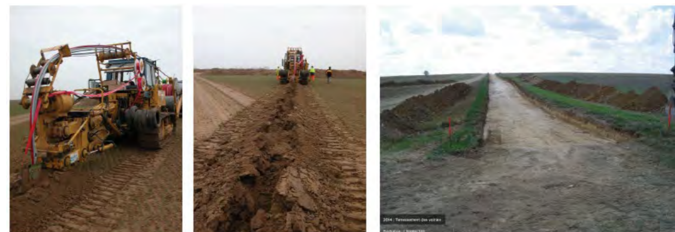
Figure 117 : exemples de travaux réalisés pour l'enfouissement des réseaux et les pistes d'accès (source : biotope, 2019)
