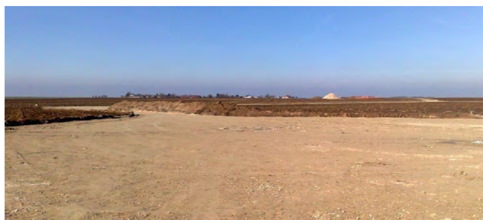
Figure 114 : Exemple d'aire de montage, grave compactée sur géotextile
